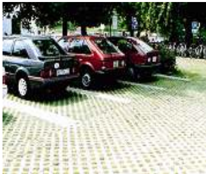
투수성 바닥 처리
